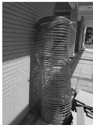
图 2 螺旋管换热器
